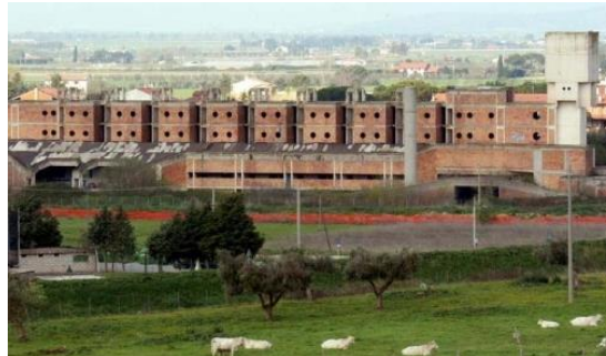
Le ex-Terme, l'ecomostro simbolo del degrado di Roselle
